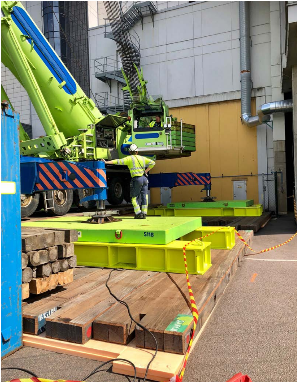
Figur 8:2 Uppställning av en mobilkran med hjälp av lastsfördelande konstruktionselement.
