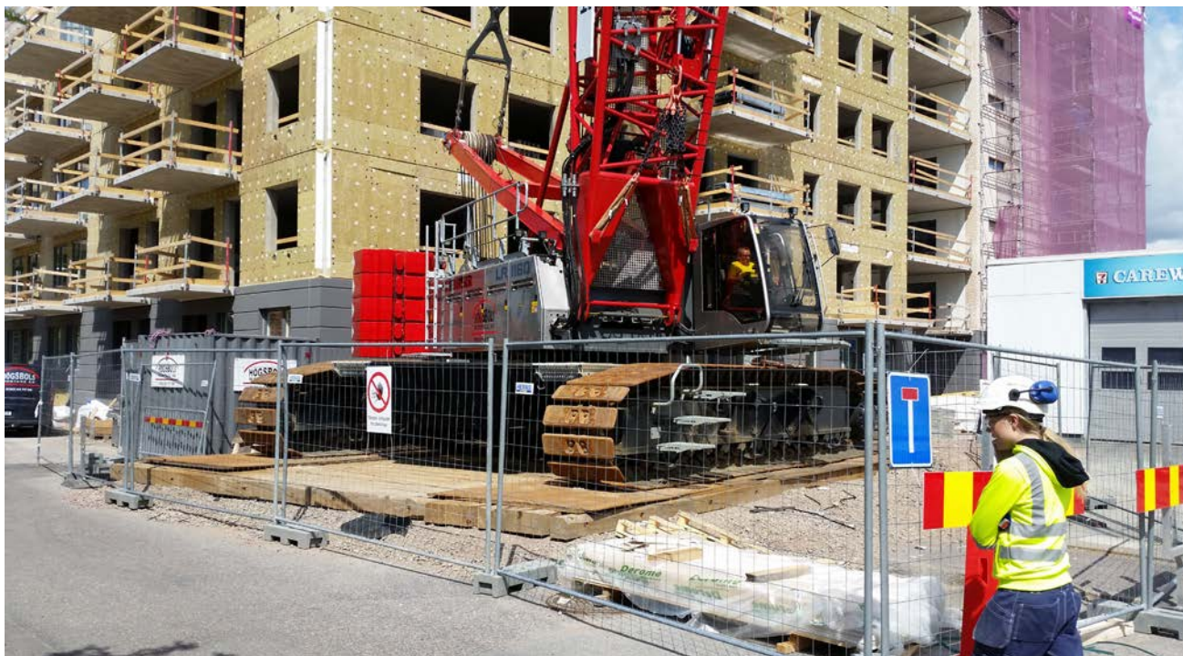
Figur 7:3 Provbekastning utfördes i samband med denna uppställning av en larvgående kran.
