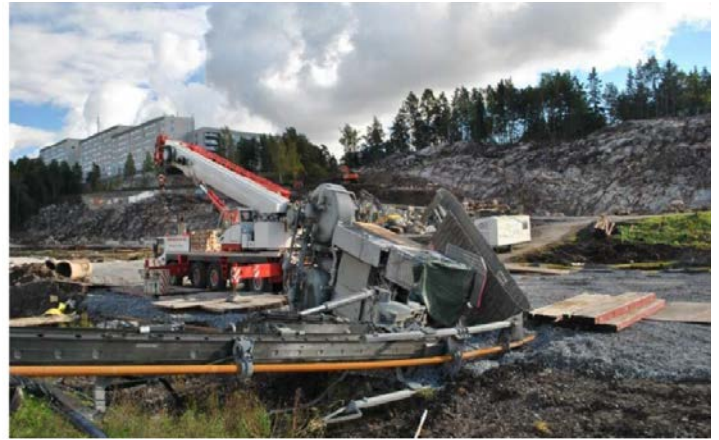
Figur 2:7 (Ovan t.h. och t.v.) Kranen välte ut på allmän väg och kunde ha skadat både tredje man och egna arbetare. Det är viktigt att ha ett ordentligt säkerhetsavstånd eller att ha flaggvakt, avstängningar eller andra skyddsanordningar där inte säkerhetsavståndet kan hållas.
