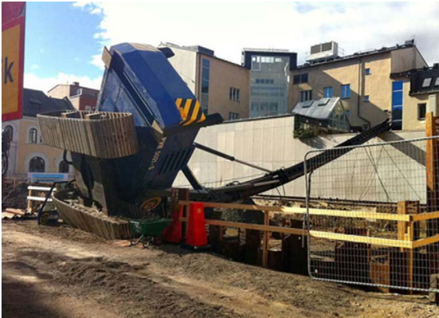
Figur 2:7 (Ovan t.h. och t.v.) Kranen välte ut på allmän väg och kunde ha skadat både tredje man och egna arbetare. Det är viktigt att ha ett ordentligt säkerhetsavstånd eller att ha flaggvakt, avstängningar eller andra skyddsanordningar där inte säkerhetsavståndet kan hållas.
