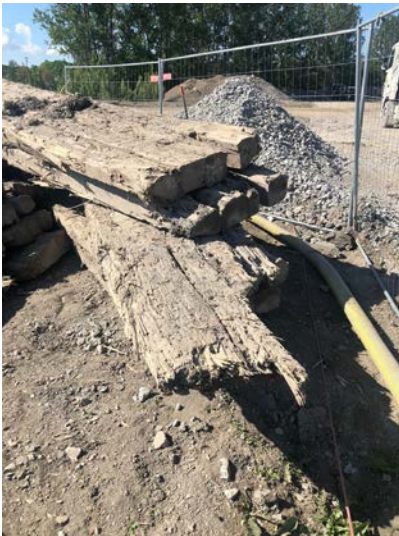
Figur 8:1 Stockmattor i dåligt skick.
