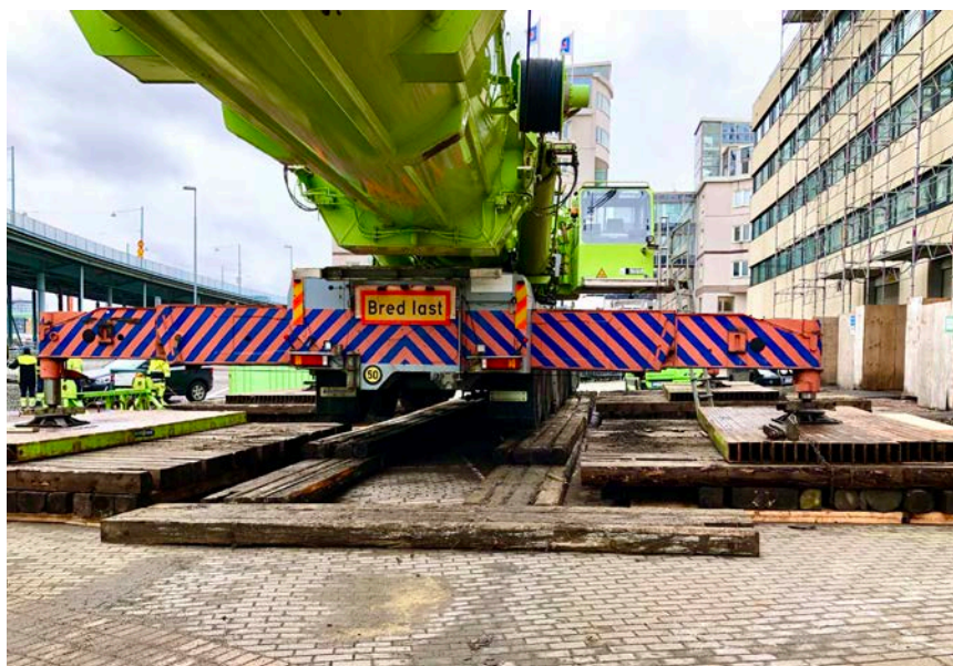
Figur 7:2 Provbekastning utfördes i samband med denna uppställning av en mobilkran.
