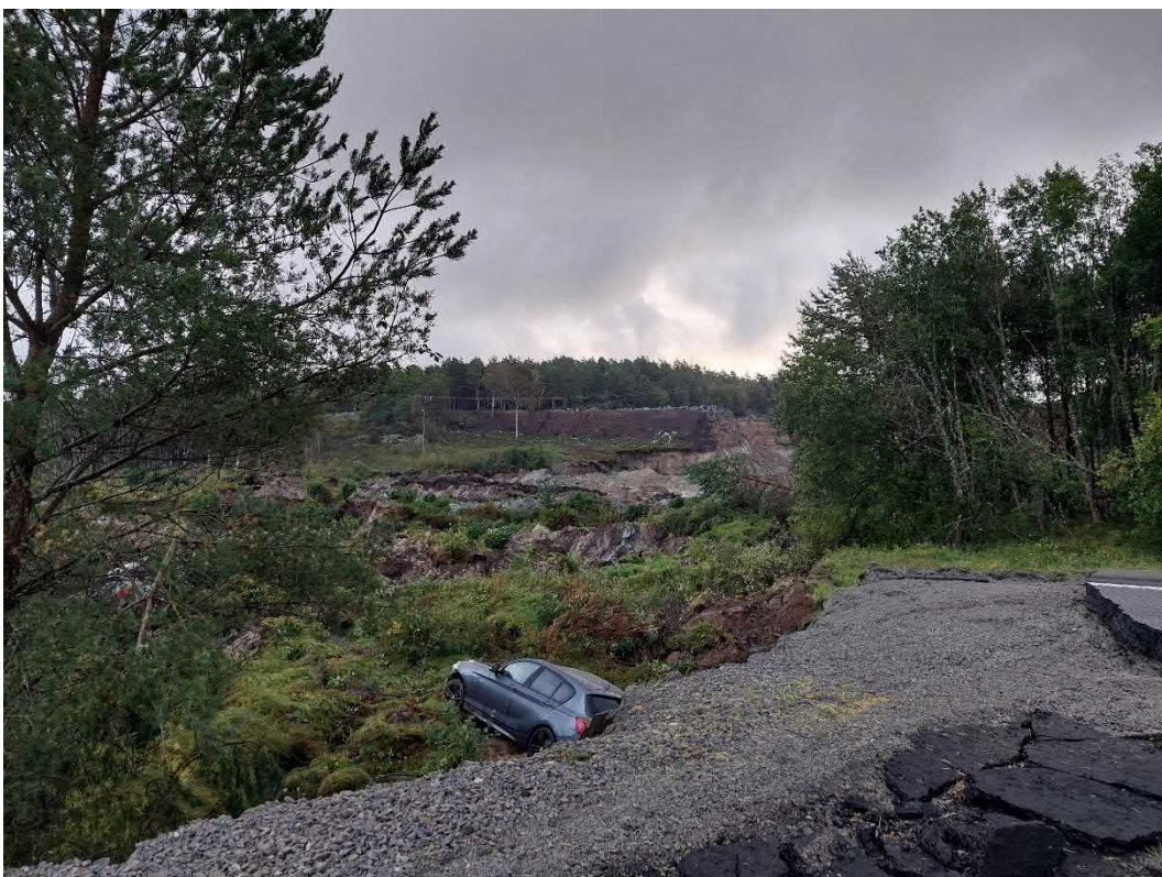
Foto 2. Bild över skredets centrala delar, vid norrgående påfartsramp. Avskuren E6 i förgrunden. Fotoriktning Ö. Foto: SGI.
