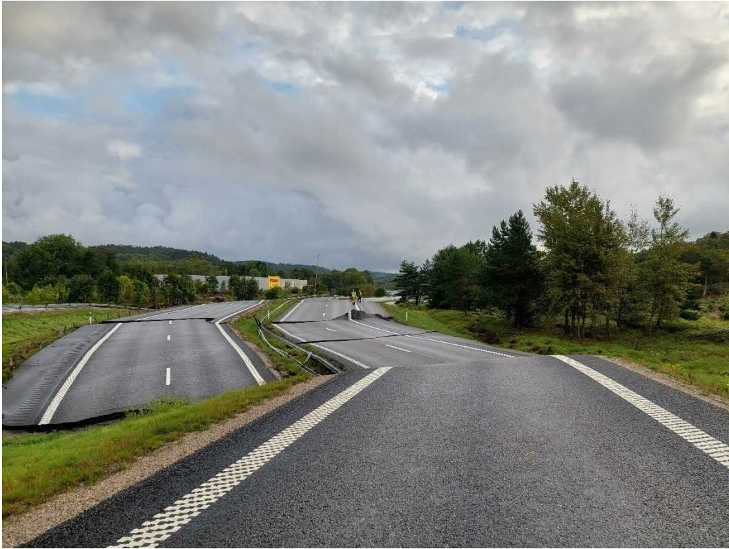
Foto 3. Södergående avfartsramp i förgrunden, förflyttad E6 i bakgrunden. Fotoriktning: NÖ. Foto: SGI.
