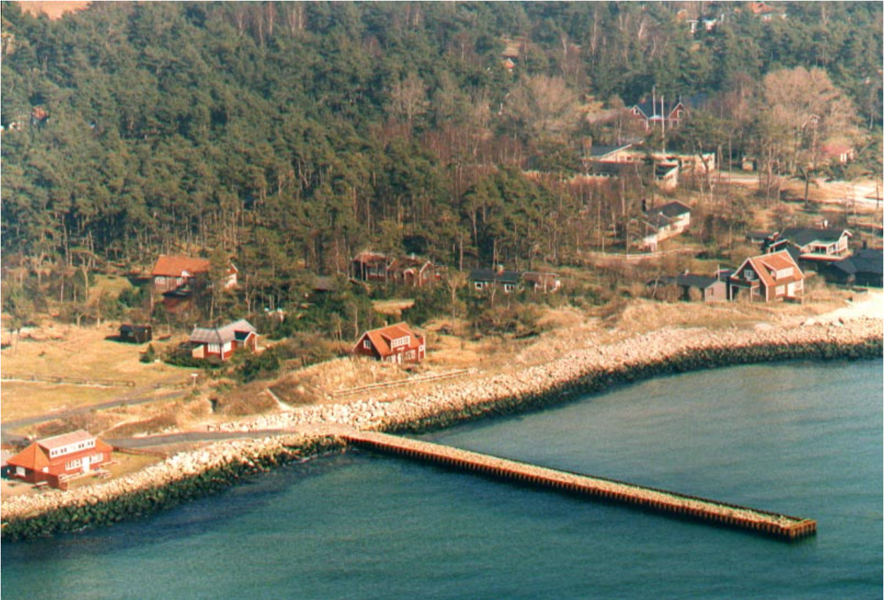
Figur 5.2 Hövd längs kuststräcka i Ystads kommun som är kraftigt utsatt för erosion. På bilden syns även stenstrandskoning. (Foto: Ystads kommun).
