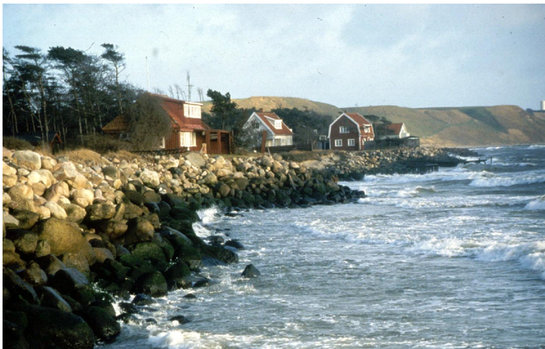
Figur 8 Den vanligaste typen av strandskoning utgörs av block eller sprängsten som läggs ut längs kuststräckor med erosionsproblem (Foto: Hans Hanson).
