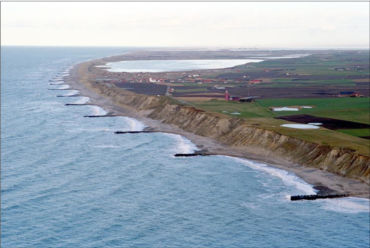
Figur 4 En serie hövder längs Danmarks Nordsjökust, vilket stabiliserar en längre kuststräcka och bildar en tandad kustlinje (Kystdirektoratet, Danmark).
