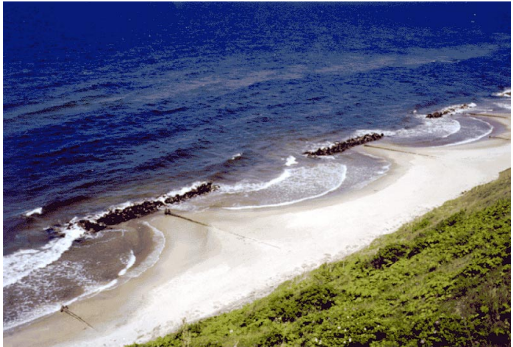
Figur 14 Vanligast uppförs en serie friliggande vågbrytare, vilket resulterar i en kustlinje (Kystdirektoratet, Danmark). Bilden visar en tydlig tombolobildning.
