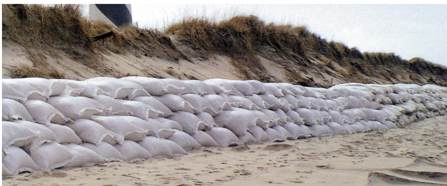
Figur 11 Enklare form av strandskoning i form av sandfyllda säckar (USGS, 1995).
