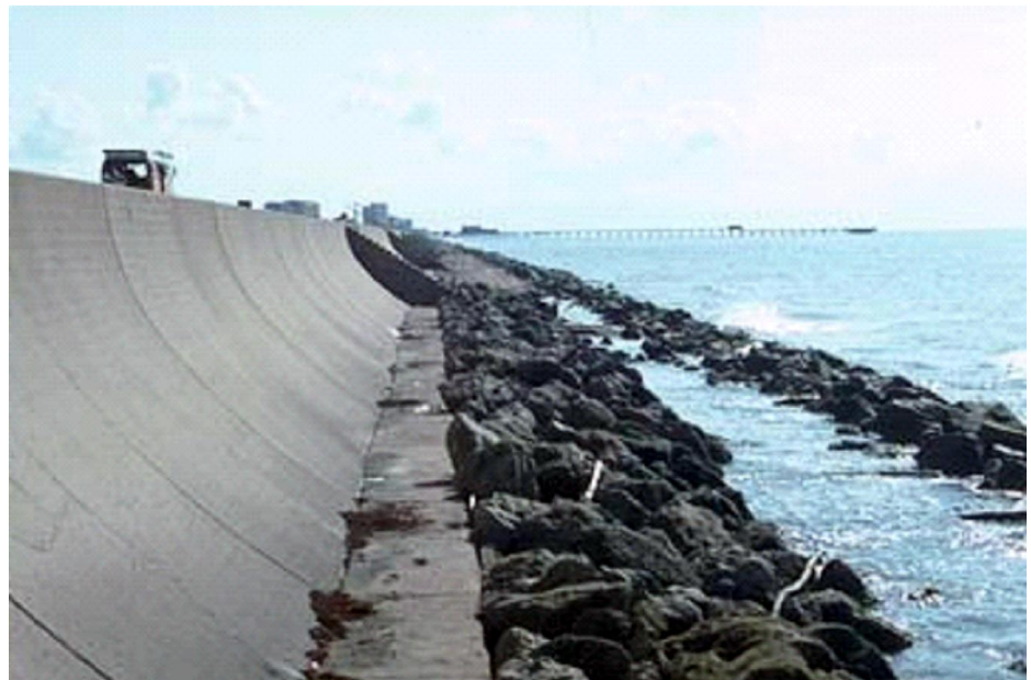
Figur 10 Exempel på strandskoning i form av betongmurselement (CERC, 1984).
