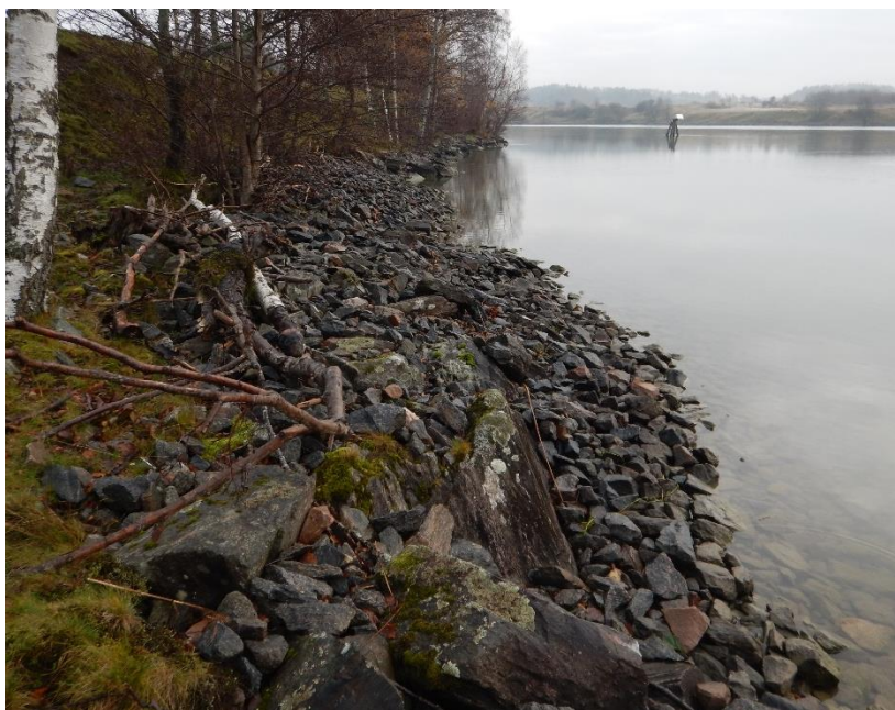
Figur 6-3 Äldre erosionsskydd längs med älvstranden. Områdets centrala delar. Fotoriktning mot nordost. (Foto från platsbesök 2019-11-14.)
