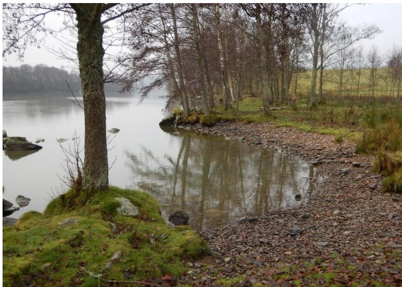
Figur 6-5. Sträcka utan väsentligt erosionsskydd på de centrala delarna av området. Fotoriktning mot sydväst. (Foto från platsbesök 2019-11-14.)
