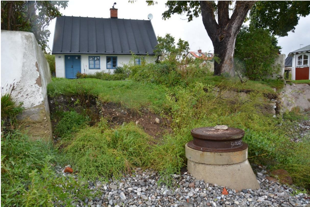
Figur 2.4 Erosionsskador på fastighet vid Smygehamn och kommunens VA-nät, Trelleborgs kommun. Foto. A. Björlin (SGI).
