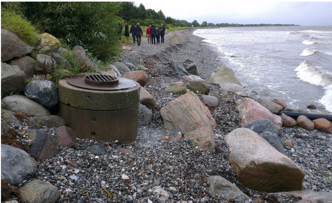
Figur 2.3 Erosionsskador på kommunens VA-nät vid Smygehamn, Trelleborgs kommun. Foto. P. Danielsson (SGI).
