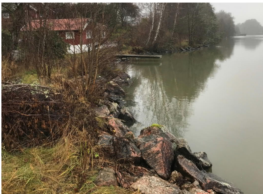
Figur 3: Sprängstensvall längs Göta Älvs strandlinje. Foto taget i nordlig riktning 2019-11-27.
